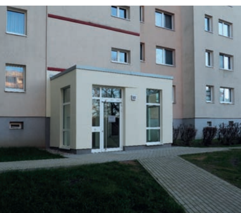
Aufzugsumbau Mehrower Allee
