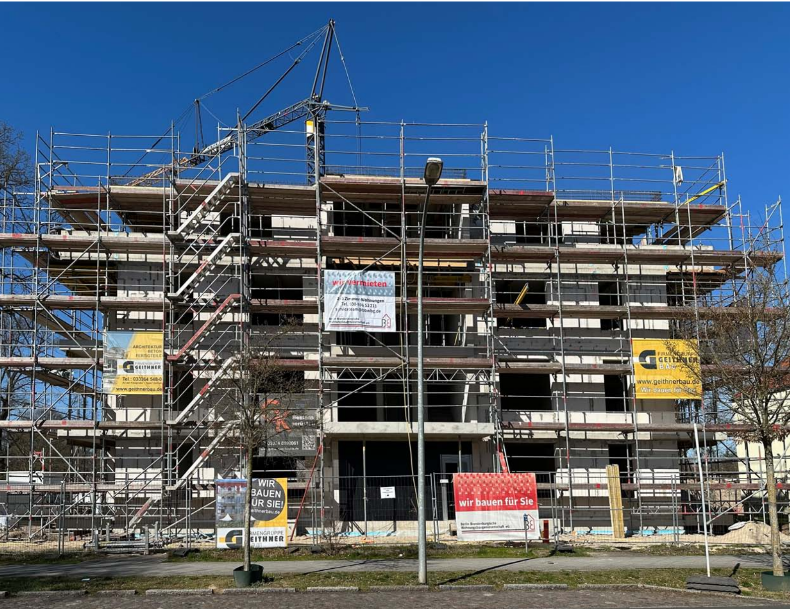
Rohbau Oranienburg Dr. Kurt-Schumacher-Str. 15
